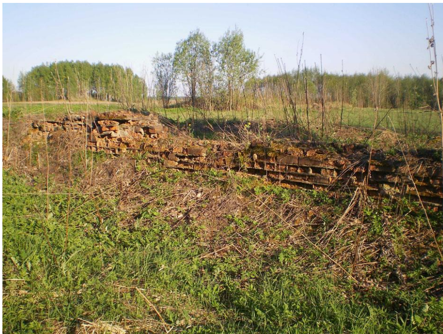
Мікалаеў. Падмурак сядзібы Заблоцкіх-Розэнаў. У міжваенным часе тут была школа (2011)
