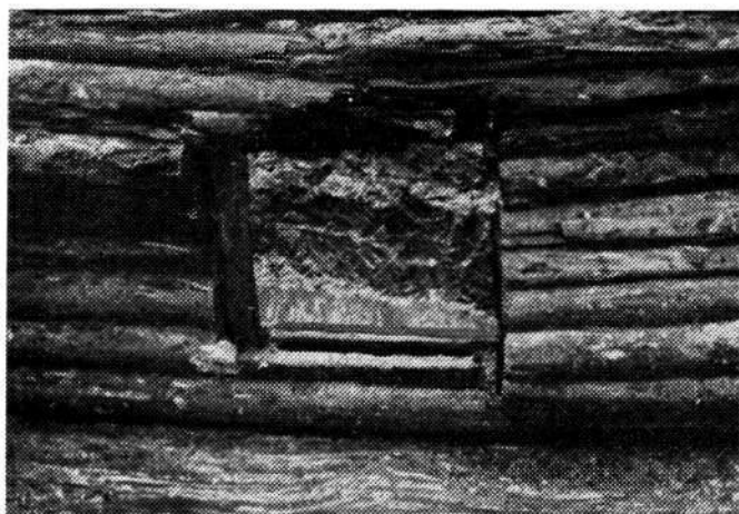
Дверной проем постройки 6
