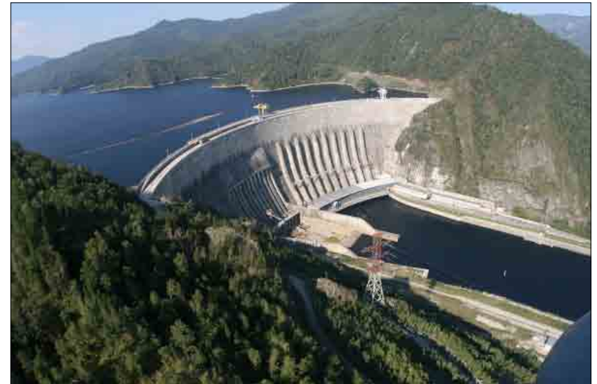
Іл. 2.11. Саяна-Шушанская гідраэлектрастанцыя, Расія.
