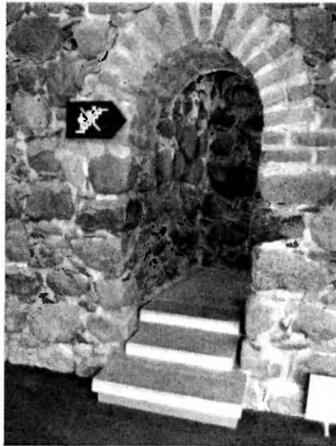
Медніцкі замак. Вежа-данжон. Рэканструяваны ўваход на лесвіцу- тунэль. Прыступкі выкананы з бетону. Здымак 2012 г., кастрычнік.
