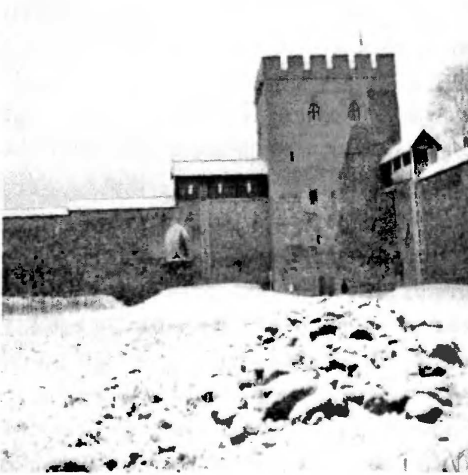
Медніцкі замак. Адноўленая вежа-данжон. Выразна відаць мяжу паміж каменнымі аўтэнтычнымі канструкцыямі (справа) і рэканструяванай цаглянай муроўкай (злева). З баявых галерэяў рэканструяваных фрагментаў сцен спускаюцца пажарныя лесвіцы. Здымак 2012 г., кастрычнік.
