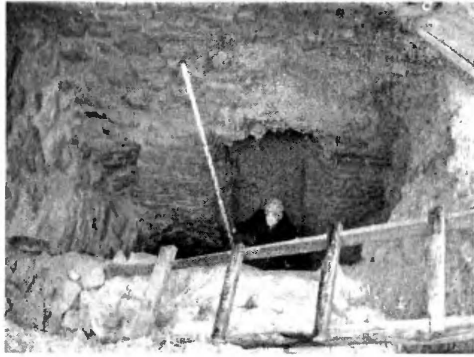
Крэўскі замак. Княская вежа. Ускрыты арачны праём уваходу на лесвіцу-тунэль. Здымак 2012 г., кастрычнік.
