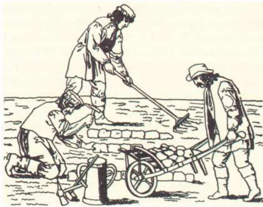
Будаўніцтва шашэйнай дарогі
