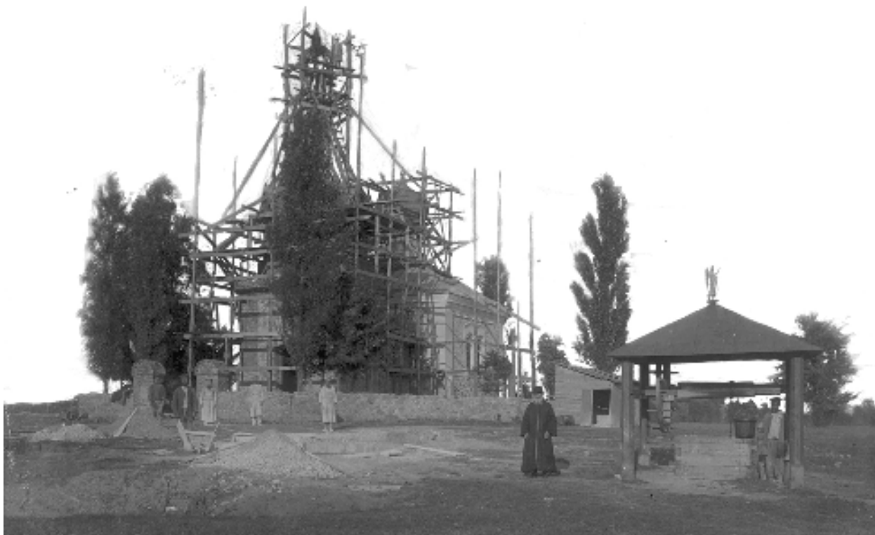
Ракавічы. Ремонт царквы каля 1900 г.
