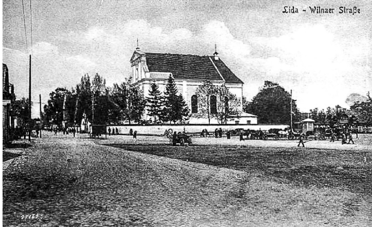
Паштоўка 1917 года. Злева ідзе электрычная лінія пастаяннага току, якая мае два провады («+» і «-»).
