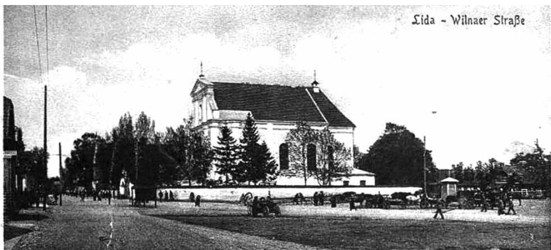
Паштоўка 1917 г., злева ідзе электрычная лінія сталага току, якая мае два драты (+ і -).
