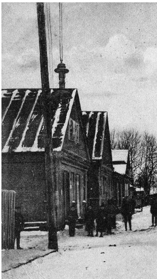
Калільны ліхтар, для запальвання апушчаны ўніз
