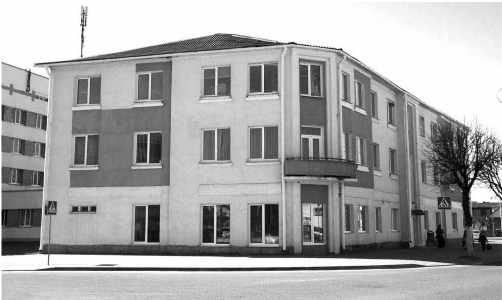
Будынак сучаснай паліклінікі. Першы здымак – будынак у 1959 г., апошні – паліклініка ў 2013 г.
