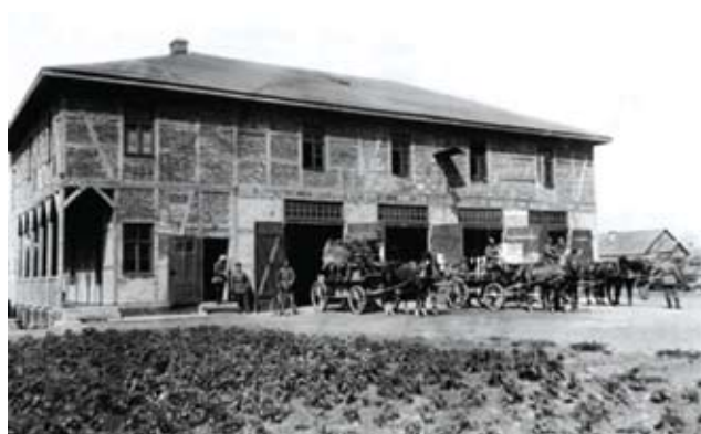
Фахверкавы будынак пажарнай аховы, пабудаваны ў 1916 г. на вул. Віленскай
