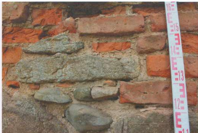
Іл. 34. Уключэнне каменных блокаў у цагляную муроўку на паўднёва-заходняй сцяне Крэўскага замка (з вонкавага боку). Фотаздымак: 25 мая 2022 г.
