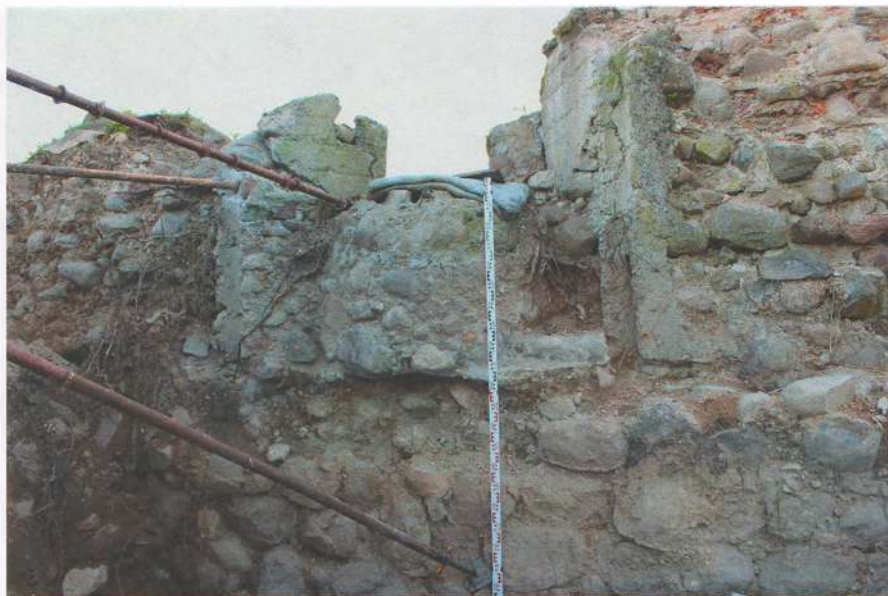
Іл. 20. Цylіндрична аснова кулямётнага стала і амбразура ДАКа з боку замкавага дзядзінца. Умацаванні канструкцыі ДАКа падчас расчысткі. Выгляд з поўначы. Фотаздымак: 29 ліпеня 2022 г.
