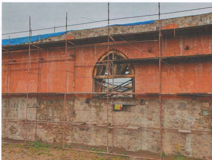
Іл. 41. Рэканструяваная Малая брама і закансерваванае амбразура. Паўднёва-заходняя сцяна Круцкага замка. Знешні бок. Выгляд з поўдня. Фотаздымак: 28 кастрычніка 2023 г.
