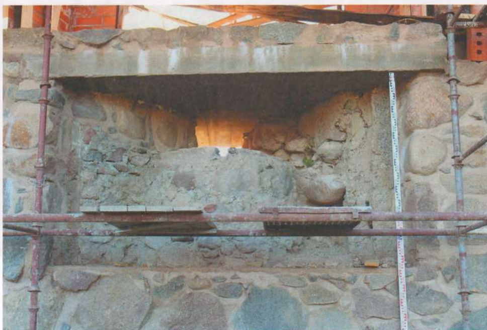
Іл. 37. Закансерваваны амбразурны вузел ДАКа (амбразура і кулямётны стол). Выгляд з паўночнага захаду. Фотаздымак: 16 верасня 2023 г.
