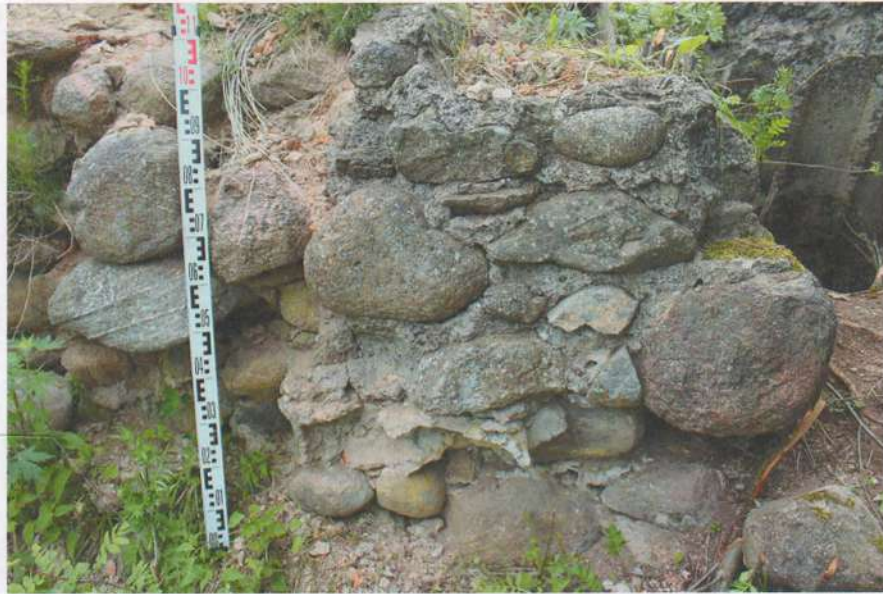
Іл. 22. Заходняя частка праёму муроўкі брамы XIV ст. на вапнавай рошчыне (злева) і бетонная вымуроўка амбразуры часоў ПСВ. Выгляд з поўдня. Фотаздымак: 13 чэрвеня 2022 г.
