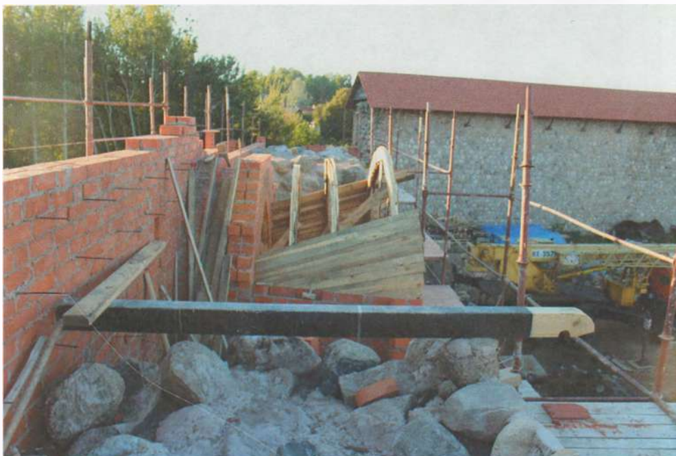
Іл. 42. Працэс рэканструявання перакрыцця аркі Малой брамы Крэўскага замка. Паўднёва-заходняя сцяна Крэўскага замка. Выгляд з усходу. Фотаздымак: 16 верасня 2023 г.
