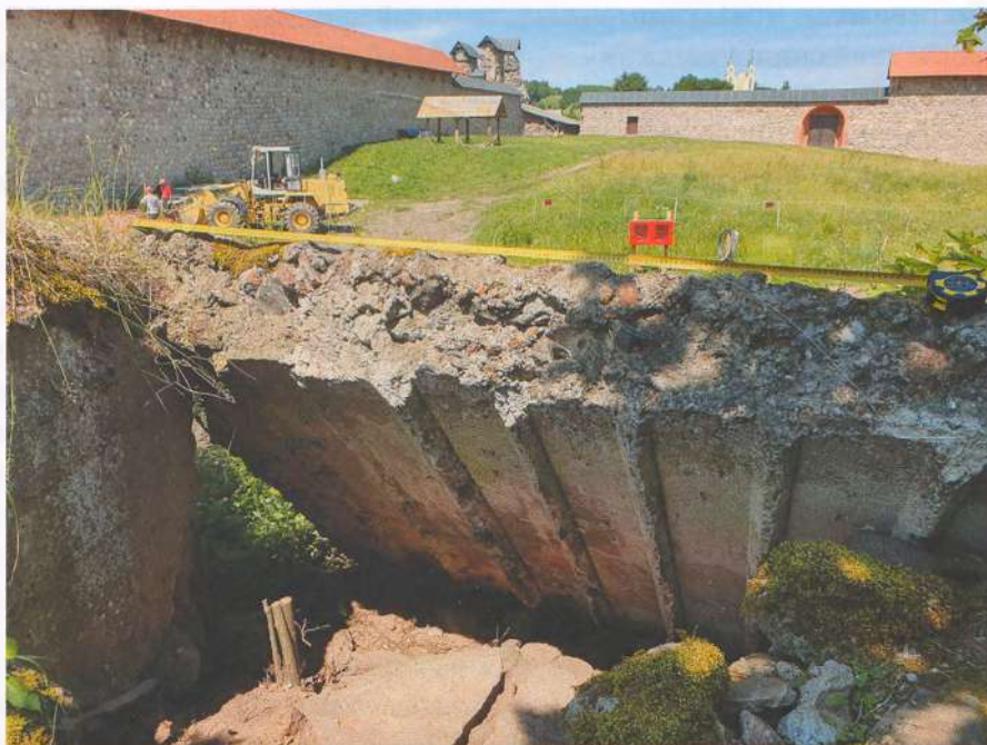
Іл. 21. Бетонная пліта ДАКа. Выгляд з паўднёвага захаду. Фотаздымак: 29 чэрвеня 2022 г.
