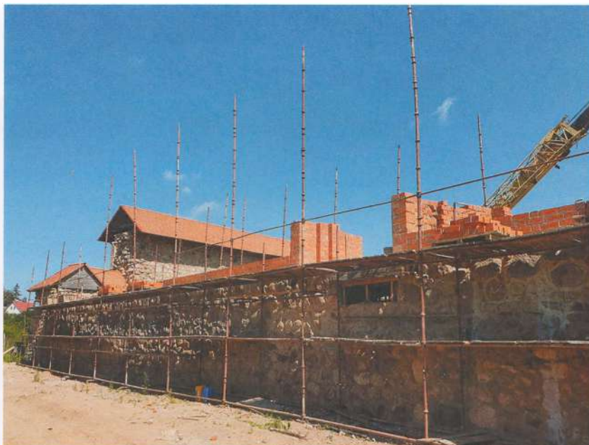
Іл. 40. Працэс рэканструкцыі Малой брамы і кансервацыі амбразуры. Паўднёва-заходняя сцяна Круцкага замка. Знешні бок. Выгляд з поўдня. Фотаздымак: 17 ліпеня 2023 г.
