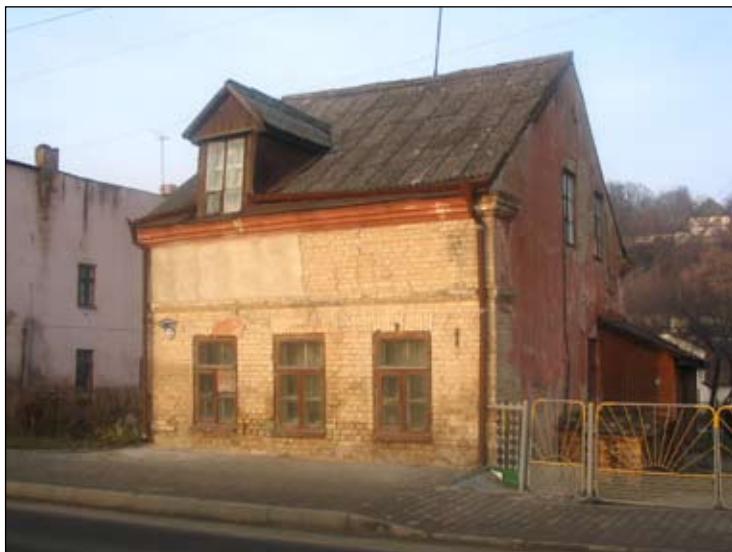
Дом па вул. Падольнай, 38
