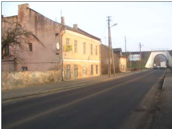
Дом па вул. Падольнай, 34
