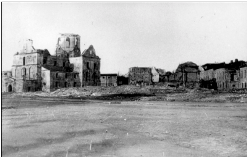
Разрушенный костел в Могилеве
