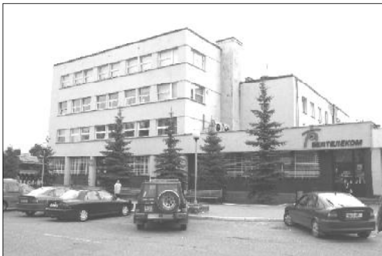
fot. . 8. Poczta w Lidzie, stan obecny, foto A. Kolyszko
