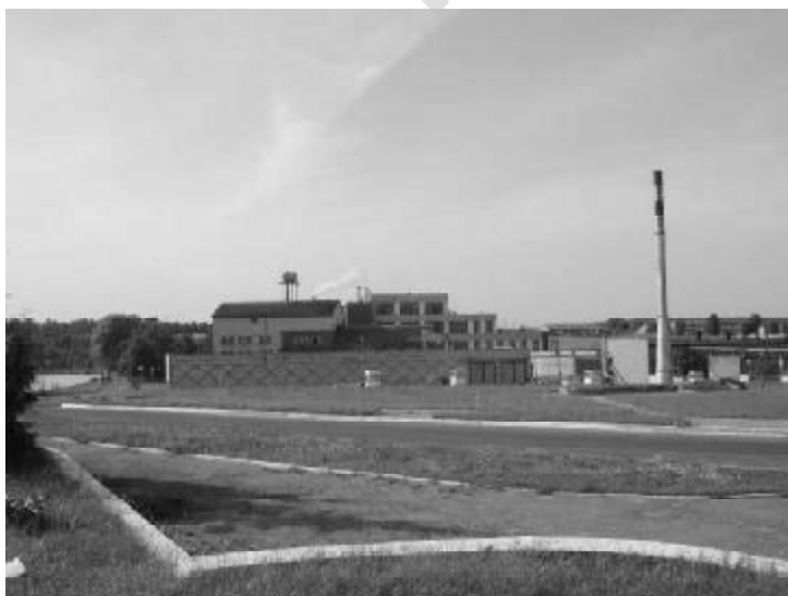
Спіртзавод. Здымак 2002 г.
