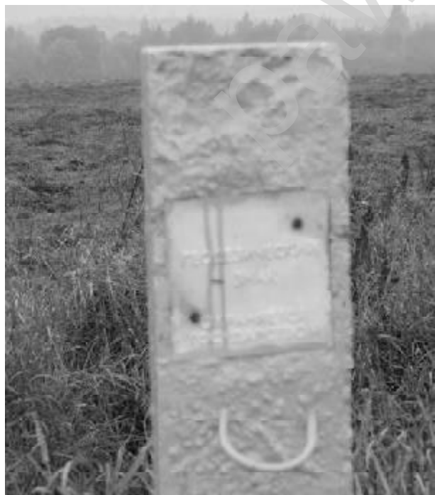
Ахоўны слупок вонкавага геадэзічнага знака пункта Дугі Струве каля в. Дакудава Лідскага раёна. На слупку надпіс: "Геодезический знак. Охраняется государством".
