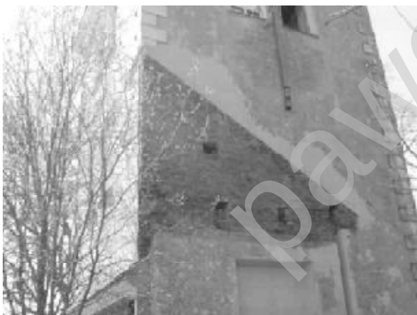
Фрагмент сцяны вежы палаца Пуслоўскіх у Дворышчы, на якой відны сляды прымыкання страхі і выемкі перакрыццяў палаца.
