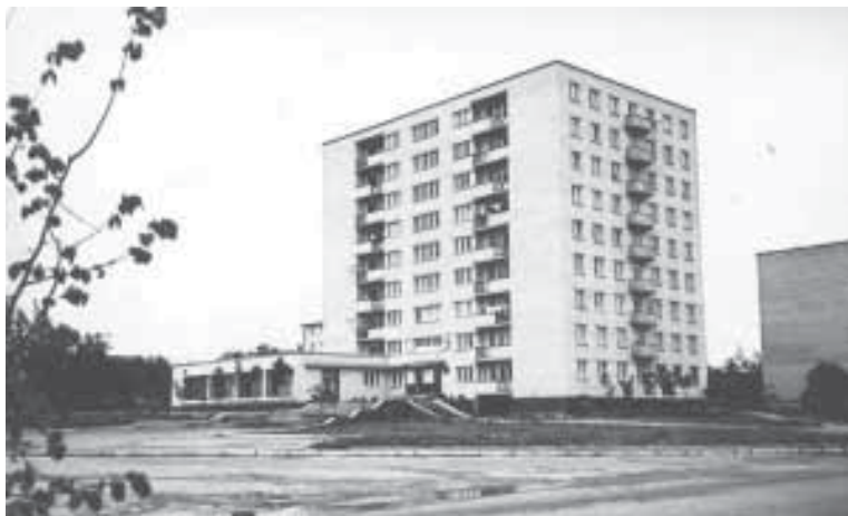
Будынак інтэрната па вуліцы Таўлая неўзабаве пасля ўводу ў эксплуатацыю
