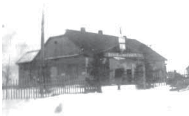
Былы будынак нямецкай камендатуры-бункер, пабудаваны ў 1943 годзе. Пасля вызвалення Лідчыны правялі рэканструкцыю і пачалі выкарыстоўваць для правядзення вучэбных заняткаў
