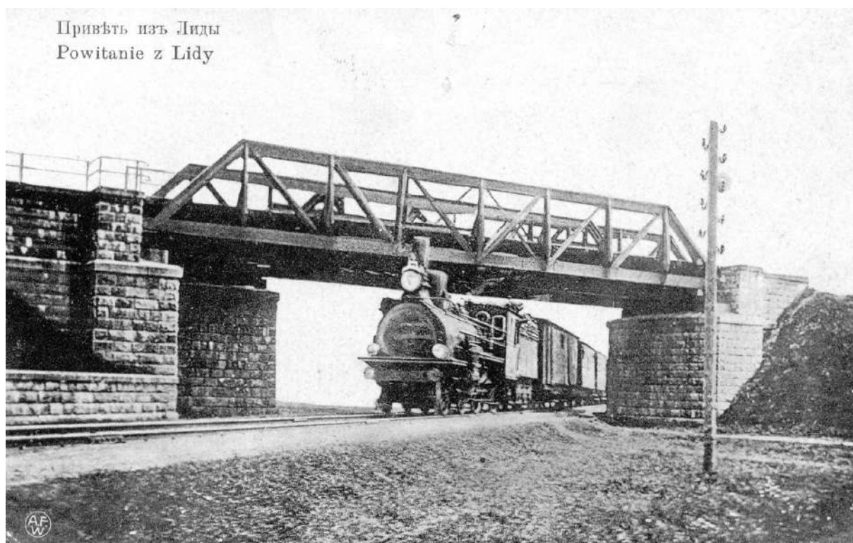
237. Wiadukt na skrzyżowaniu linii kolejowych Poleskiej i Połocko-Siedleckiej, za współczesnym szpitalem, ok. 1910 r.
