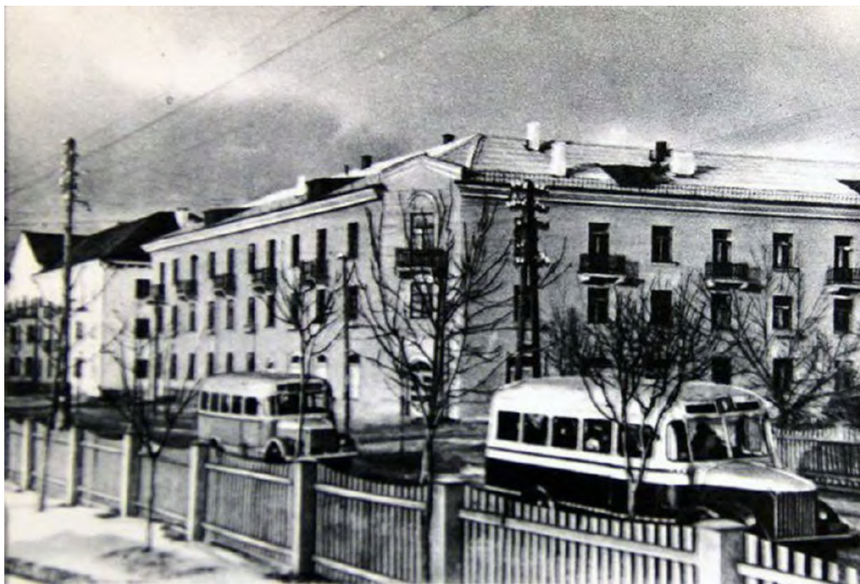
122. Budynek Fabryki Obuwia i Sklep nr 12. Połowa lat 50. XX wieku.
