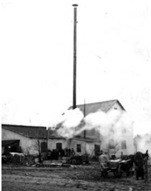
134. Lidzka elektrownia w latach 1930.
