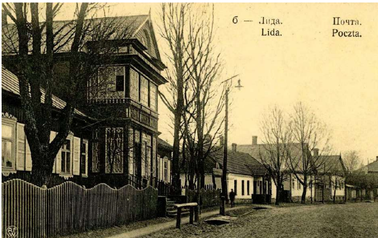
116. Budynek poczty, 1916 r. Za pocztą parterowy dom z gankiem, właściciel Pupko. Pocztówka sprzed 1914 roku.
