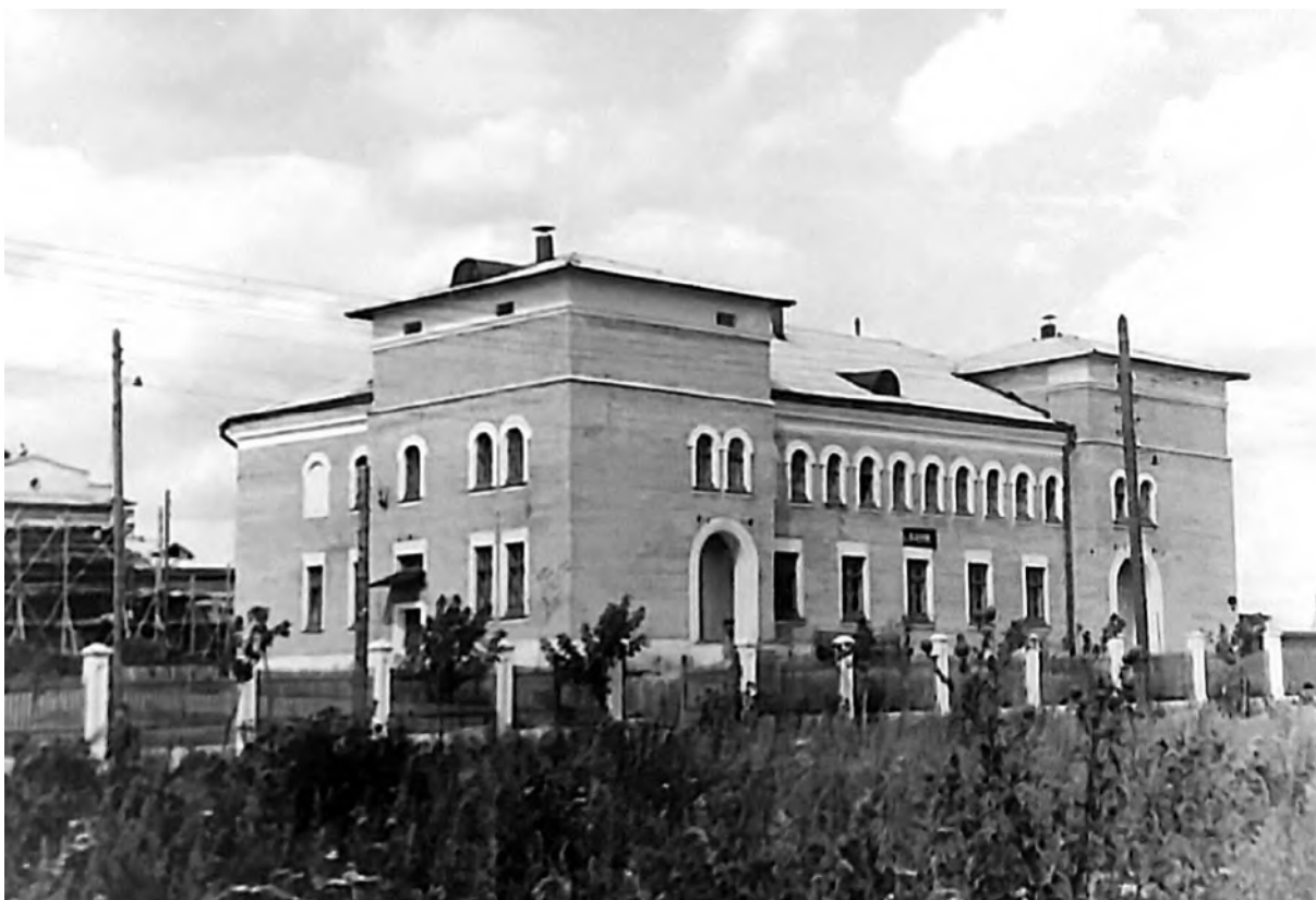
198. "Łażnia Nowa", 1959. Po lewej - w budowie "Dom Oficerski".
