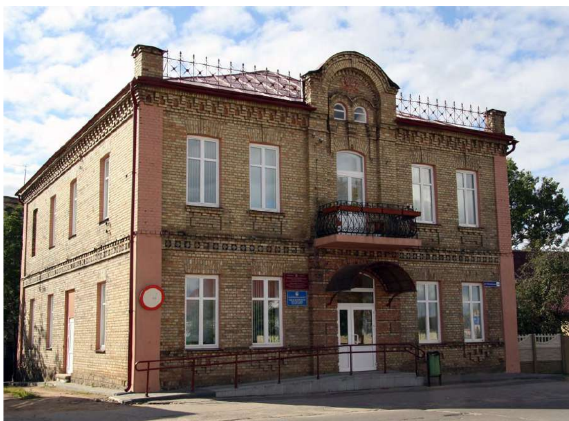
19. Dom, Zamkowa 5 przed remontem w 2019 roku, który zmienił jego wygląd.
