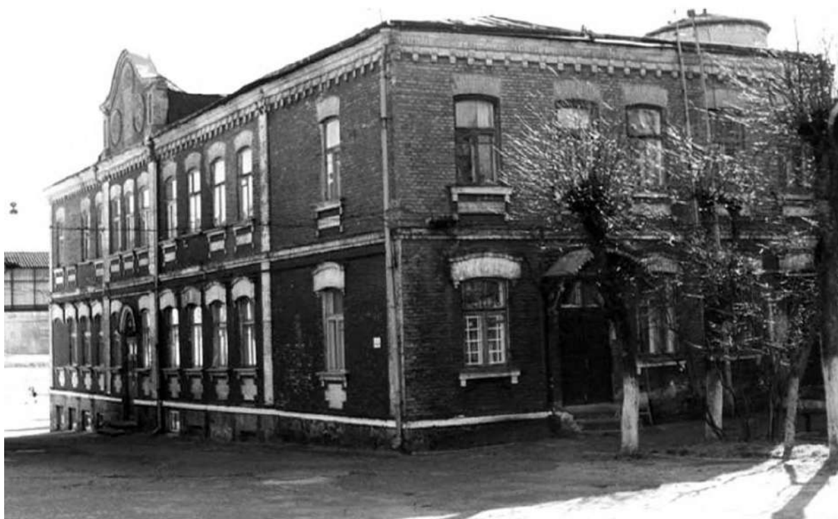
111. Dawny budynek główny browaru Papirmejstera.
