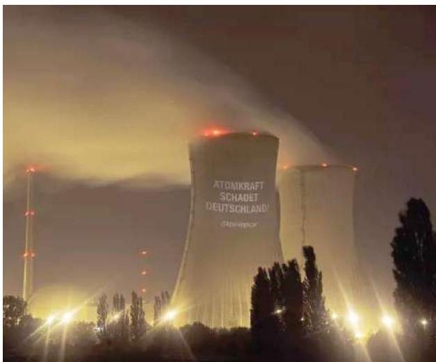
"Атамная энергія шкодзіць Германіі" - гэта сцягджэнне "Грынніс" праецыруецца на сістэмы астуджэння атамнай электрастанцыі ў Графенрайнфэльдзе, 28 верасня 2010 года Jens Meyer/ 2010 AP
