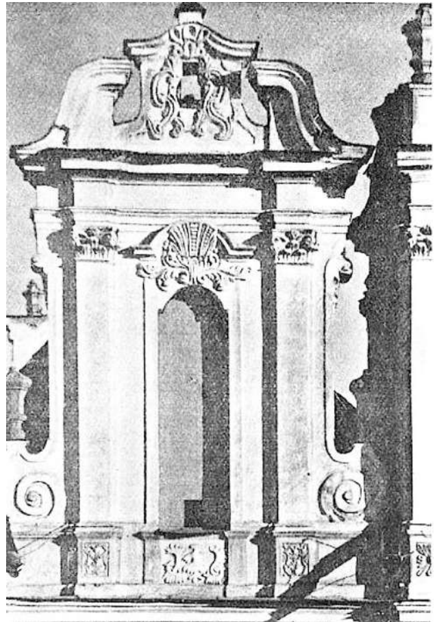
12. Вільня, касцёл св. Кацярыны, шчыт фасада
