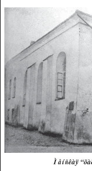
Ì à íñëäý "òäéííäý" ñ³íäíäà
